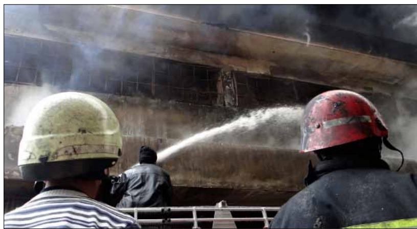
قضى الحريق على 3 عنابر في المنطقة الحرة بشكل كامل (أرشيف)
