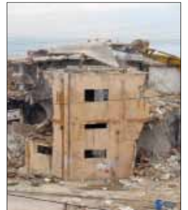
هدم مبنى الصيادين
