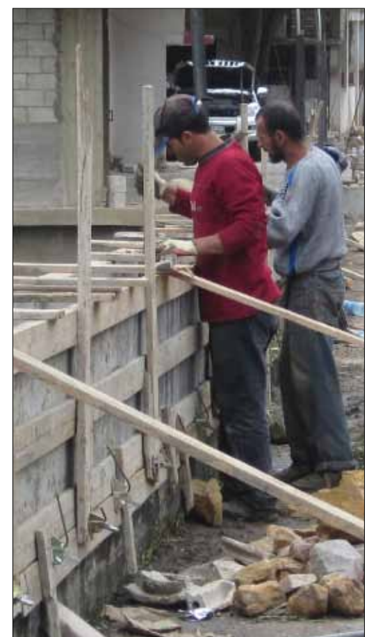
أعمال تاهيل في بضعون (الأخبار)
