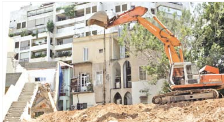
عملية هدم بيوت قديمة في منطقة الأشرافية - التباريس (الأخبار)
